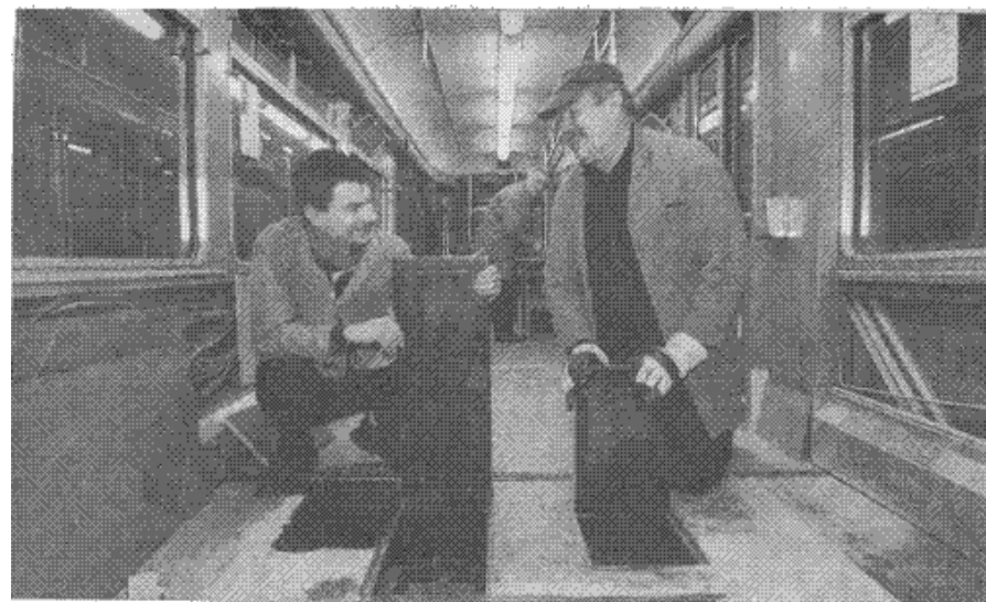
Ist der Unterboden noch stabil? Jürgen Steinbrecher (links) und Herbert Waßner prüfen das Material mit Fachverstand.
